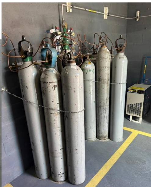
Figura 20 – Compressor de Ar e Cilindros de Nitrogênio
