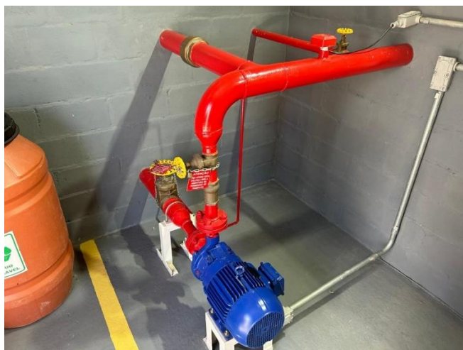
Figura 18 – Bomba de combate a incêndio
