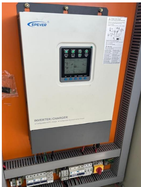
Figura 52 – Inversor dos painéis solares
