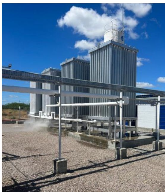
Figura 12 – Vaporizadores atmosféricos
