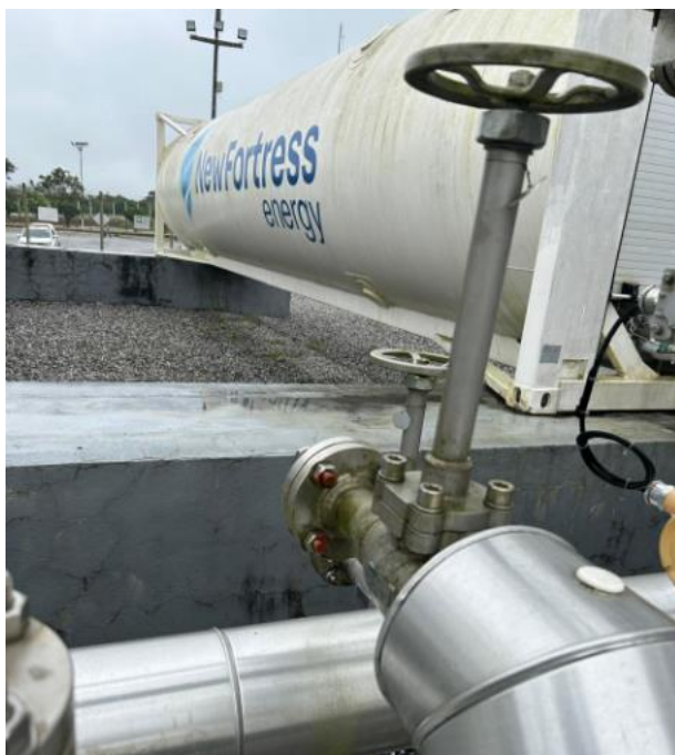
Figura 325: Previsão para montagem do 3º isotanque
