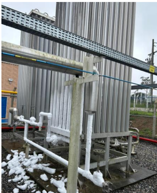
Figura 34 – Vaporizadores atmosféricos
