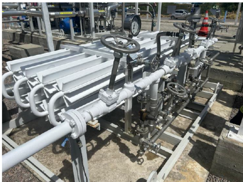
Figura 9 - SLP – Sistema levantador de pressão
