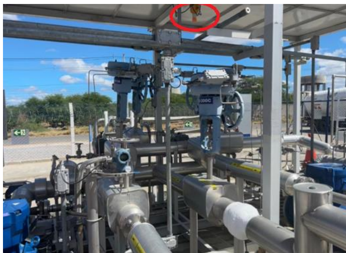
Figura 17 – Exemplo de localização de detectores de gás
