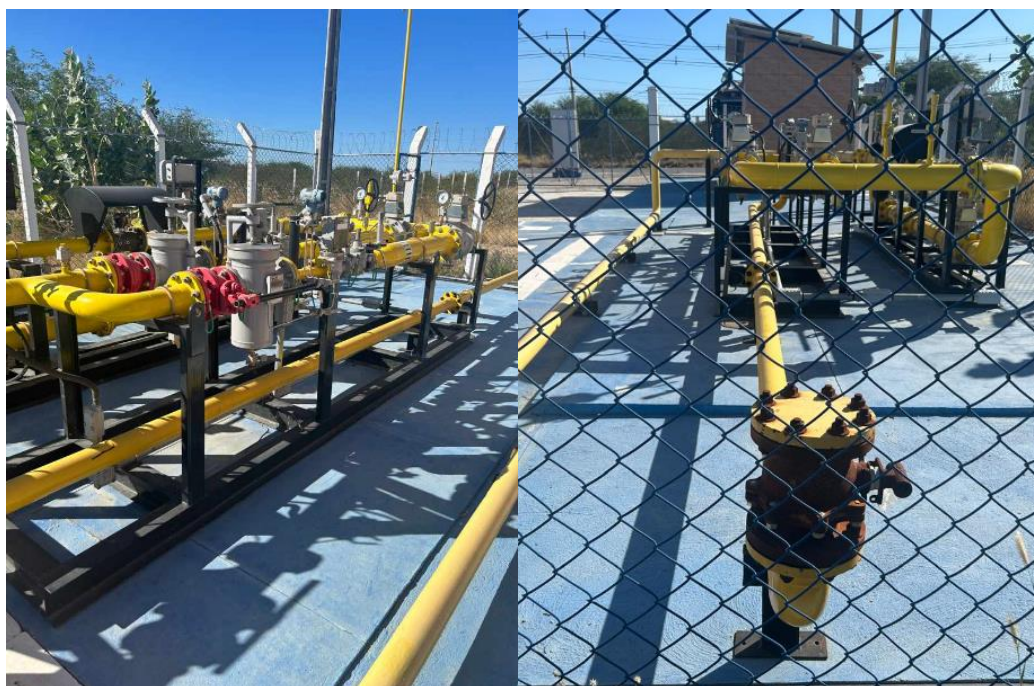
Figura 28 – Estação de Medição de Gás Natural (Copergás)
