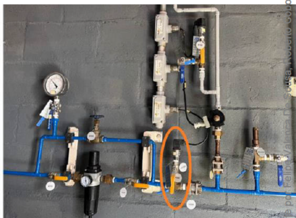
Figura 22 – Localização correta do transmissor de pressão PT-500
