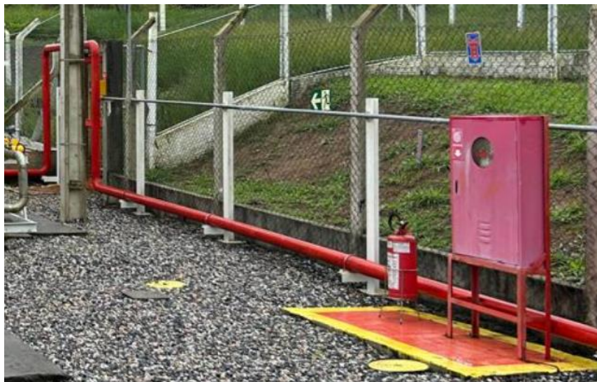
Figura 46 – Sistema de combate a incêndio
