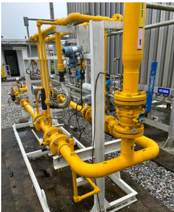
Figura 44 - Skid de Regulação de Pressão
