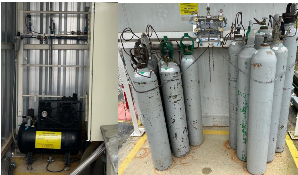
Figura 49 – Compressor de Ar e Cilindros de Nitrogênio
