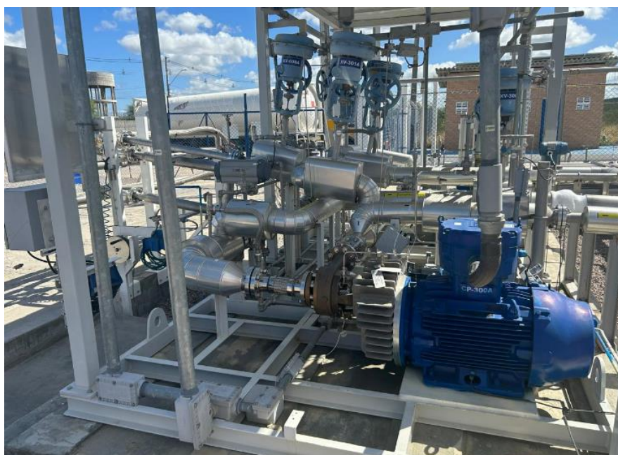
Figura 2: Bombas de descarregamento
