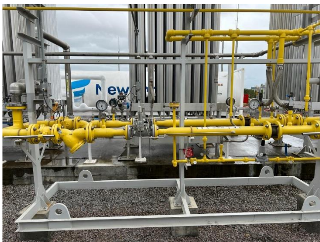
Figura 16 - Skid de Regulação de Pressão Petrolina
