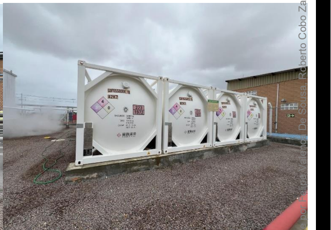
Figura 19 – Bacia de contenção
