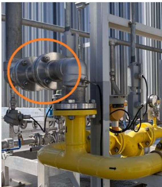
Figura 14 – Carretel (spool) instalado em substituição à XV-201
