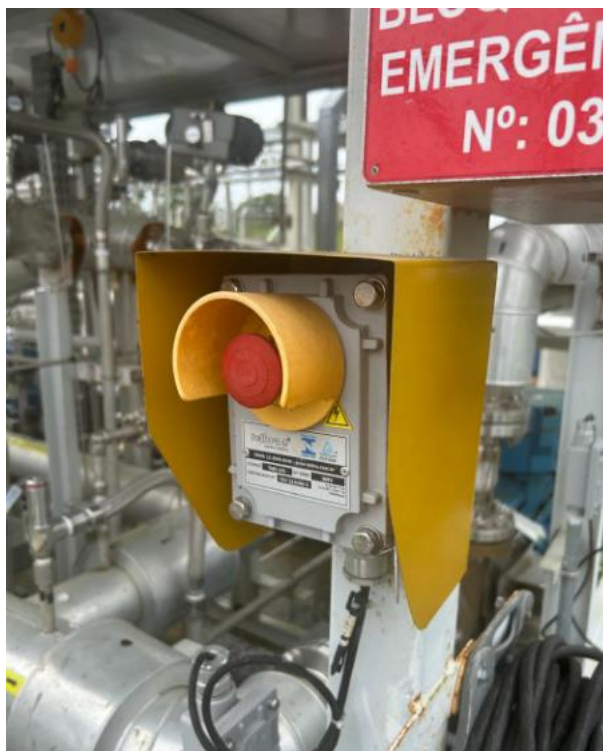
Figura 47 – Botoeira de emergência da planta
