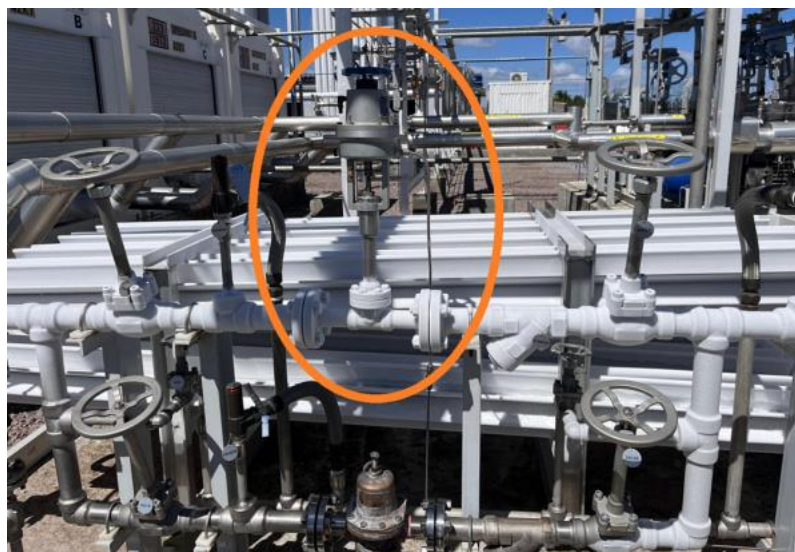
Figura 11 – Válvula pneumática
