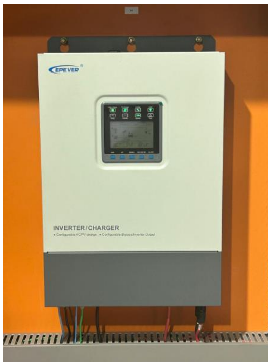
Figura 26 – Inversor das placas solares
