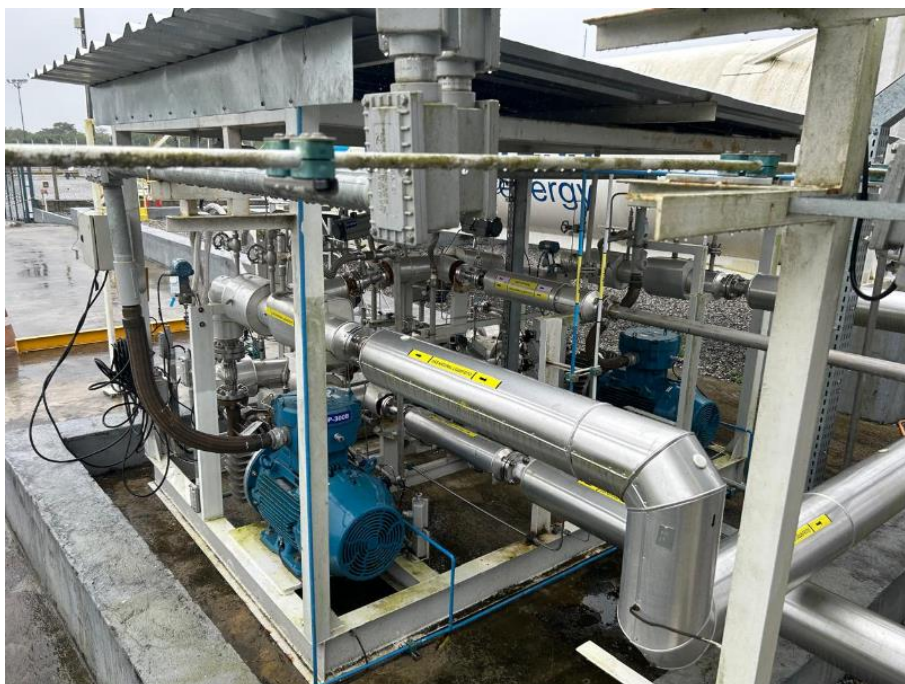
Figura 31 – Bombas de descarregamento de GNL
