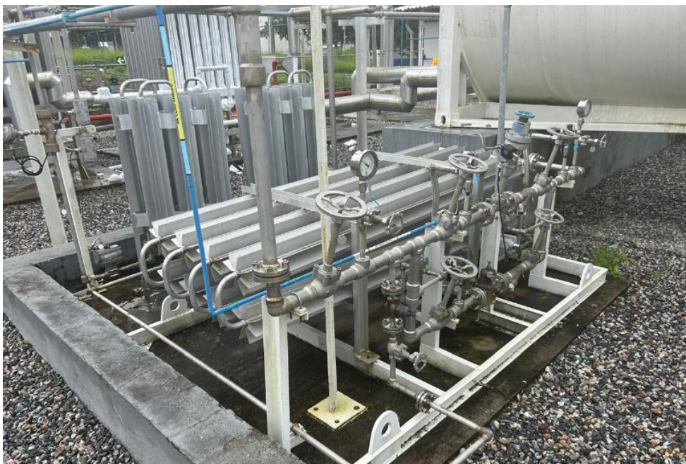
Figura 41 - SLP – Sistema levantador de pressão
