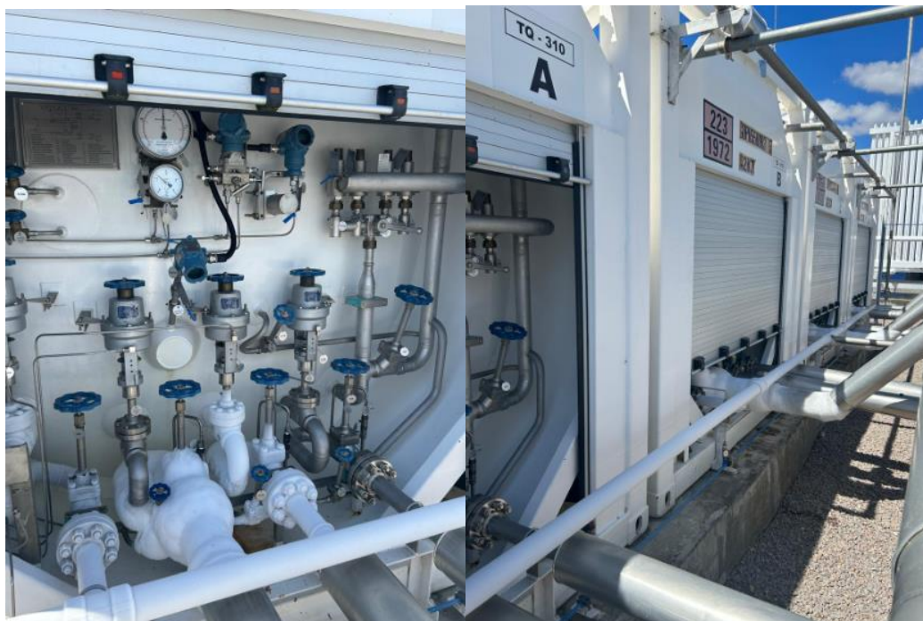
Figura 4 - Válvulas dos isotanques fixos
